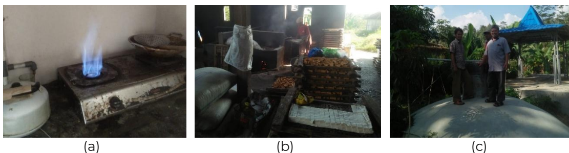
Gambar 3. (a) Hasil biogas untuk memasak, (b) industri pengolahan tahu dan (c) digester serta impal pengolahan limbah industri tahu milik KLBS
